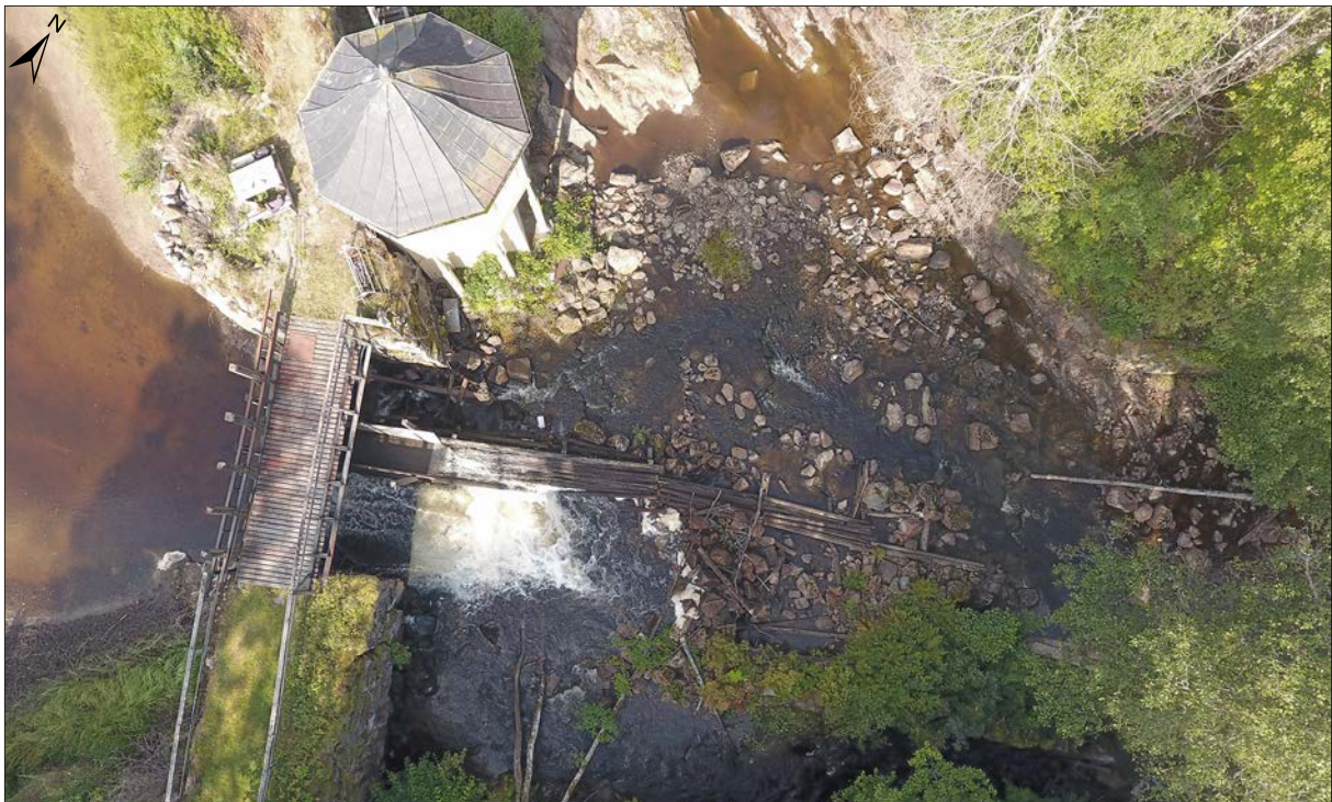
Figur 35. Flottningsrännan hölls på plats i åfåran av stora mängder sten. Lodfoto.
