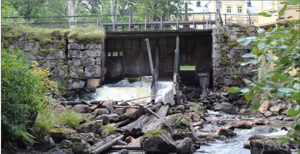
Figur 29. Södra utskovet med dammluckor. Foto från öster.
