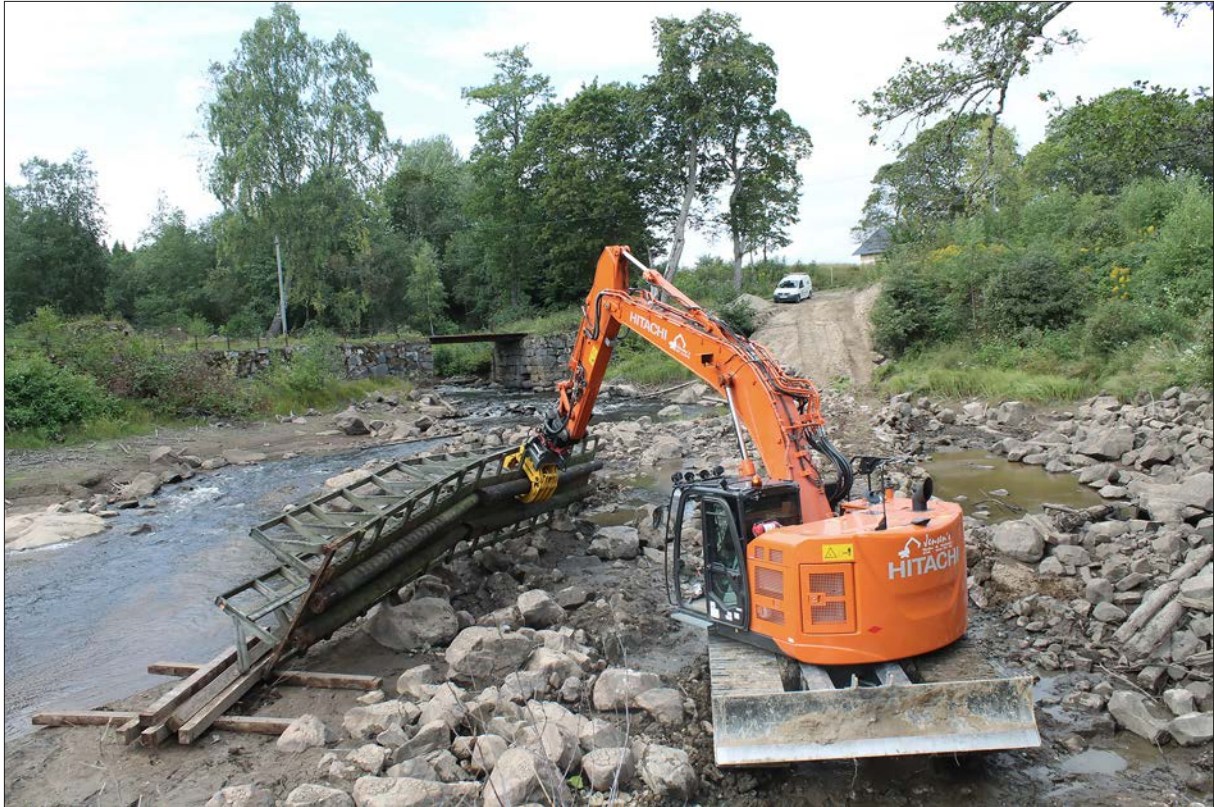
Figur 15. Arbete i dammen. Foto från sydost.
