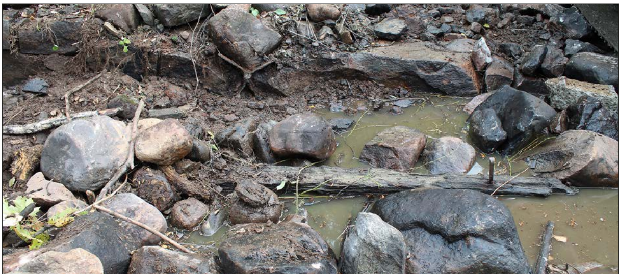
Figur 38. Delar av fundamentet till hjulgraven rensades fram i samband med att flottsranne avlägsnades. Foto från norr.
