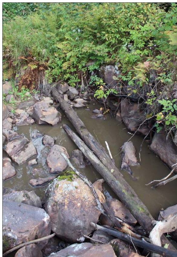
Figur 39. Längs med fundamentet till hjulgraven löpte en konstruktion av stockar. Foto från väster.
