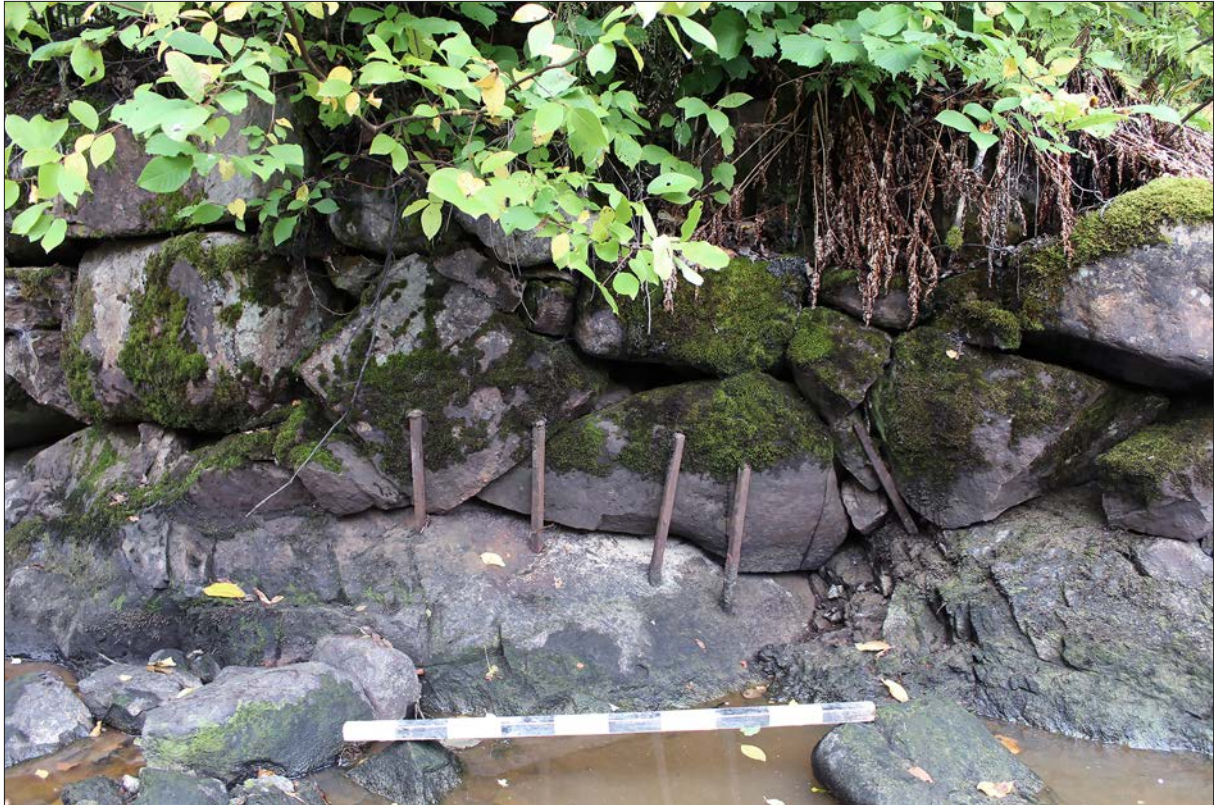
Figur 41. Där den stensatta kanten börjat röra sig har man förstärkt den med järnstänger. Foto från nordväst.
