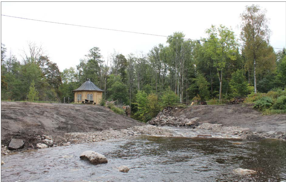
Figur 28. Dammvallen efter att arbetena slutförts. Foto från nordväst.
