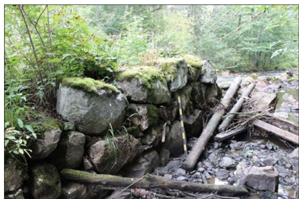
Figur 37. Stenfundamentet som utgjort norra delen i hjulgraven där vattenhjulet till stångjärnshammaren satt. Foto från väster.
