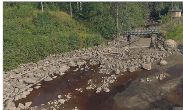
Figur 22. Timmerkonstruktion fylld med sten i dammens nordöstra kant. Foto från väster.
