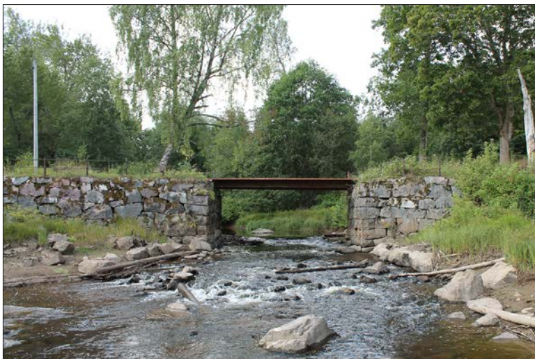
Figur 19. Närmast bron var strömmens kanter stensatta. Foto från öster.
