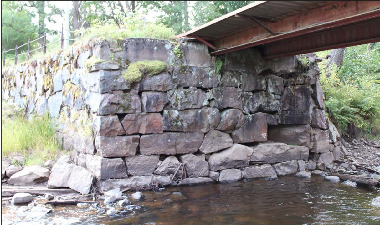
Figur 17. Stenfundament för bro vid dammens inlopp med två typer av ankarslut. Foto från öster.
