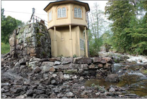
Figur 33. Stenar från det rivna fundamentet till dammluckorna återanvändes i erosionsskyddet vid lusthuset. Foto från sydost.
