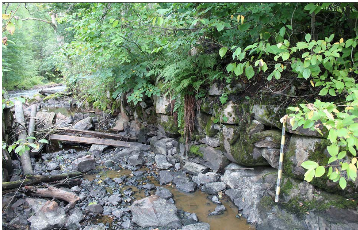
Figur 40. Hjulgravens sida mot land är stensatt med huggna stenar i tre till fyra skift. Foto från nordväst.
